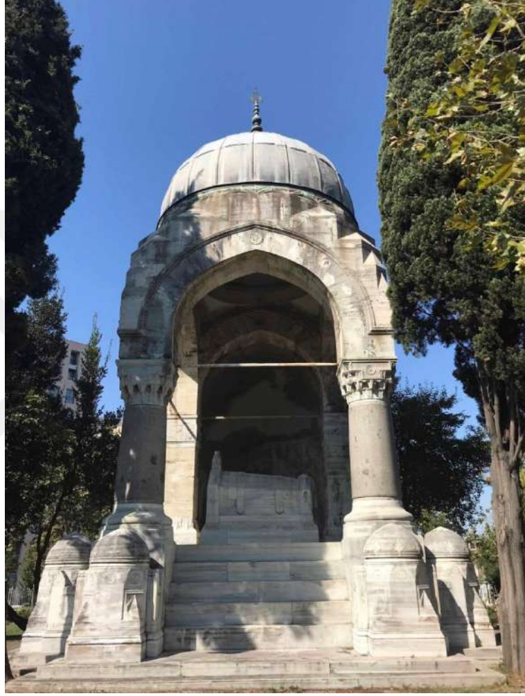
Resim 42. Mahmut Şevket Paşa Türbesi, Şişli, İstanbul
